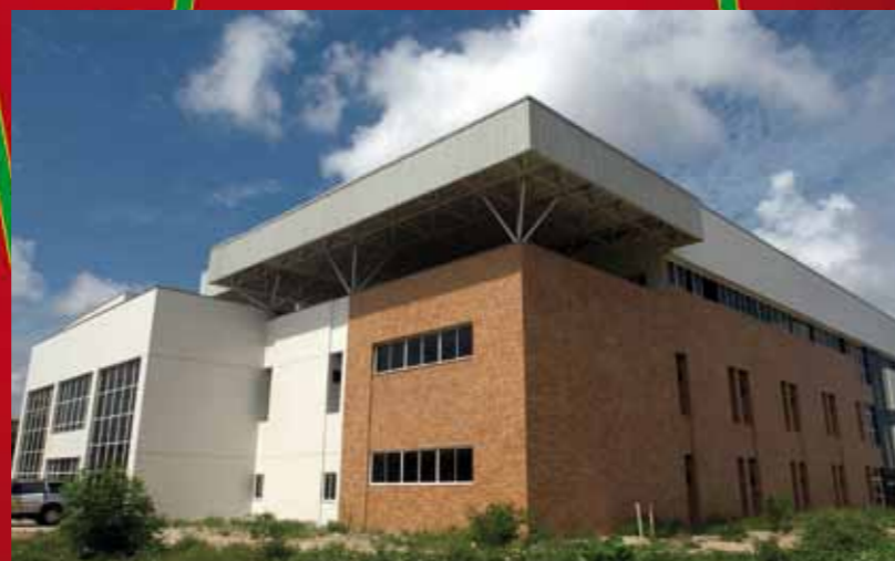
Prédio, em finalização, do futuro Núcleo de Pesquisa e Desenvolvimento de Medicamentos
