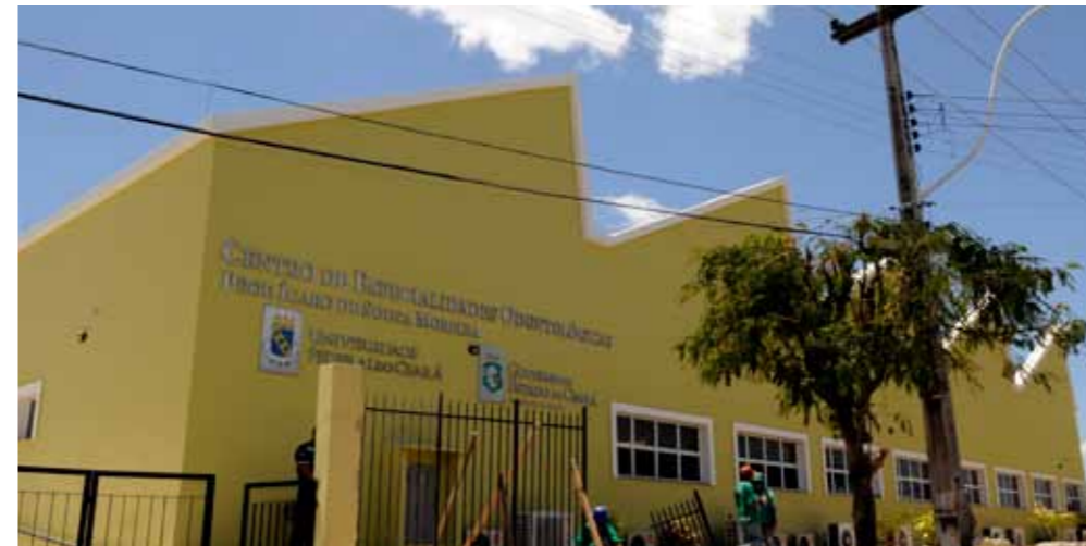
De desenho característico das edificações industriais, parede original da antiga Fábrica de Tecidos de Sobral foi preservada como fachada de entrada do Centro de Especialidades Odontológicas Professor Ícaro Moreira
