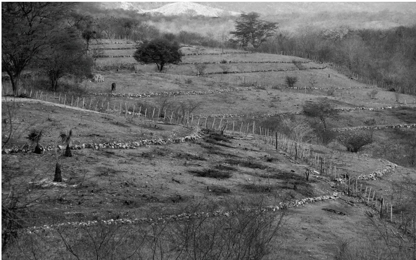
Barragens em terreno na localidade de Iguaçú, em Canindé, evitam que chuvas levem sedimentos e degradem a camada superficial do solo
