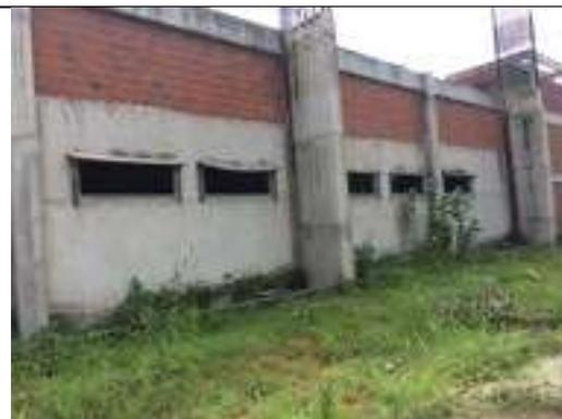
Foto 5 – Ausência de janelas de alumínio e vidros em razão de furtos ocorridos no Ginásio GYMICO, Campus do Pici da UFC – Fortaleza/CE, 02 de março de 2018.
